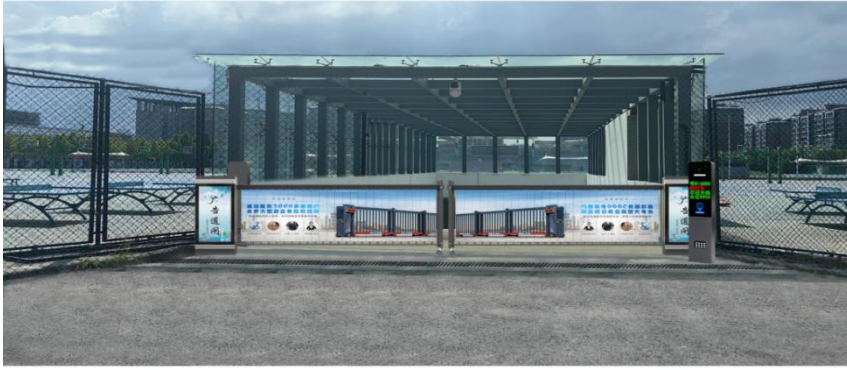
1、3、4号坡道机动车道闸样式
